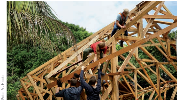
Abbildung 1: Studierende aus Deutschland und Ecuador beim Errichten der Holztragstruktur
